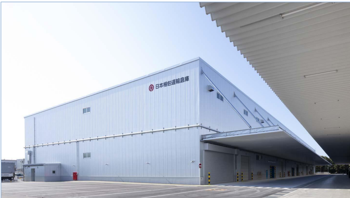
第二倉庫外観(近景)
