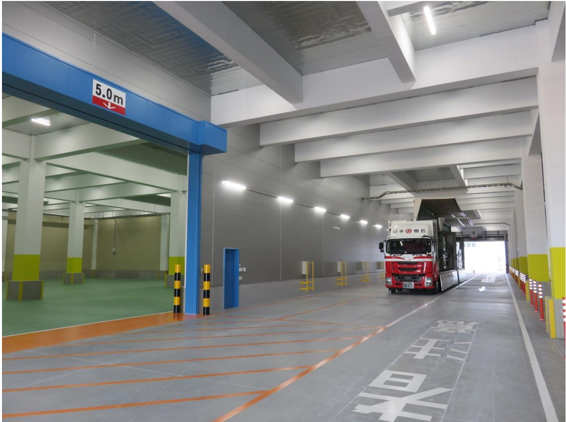
倉庫内に設置された屋内荷役ピット
