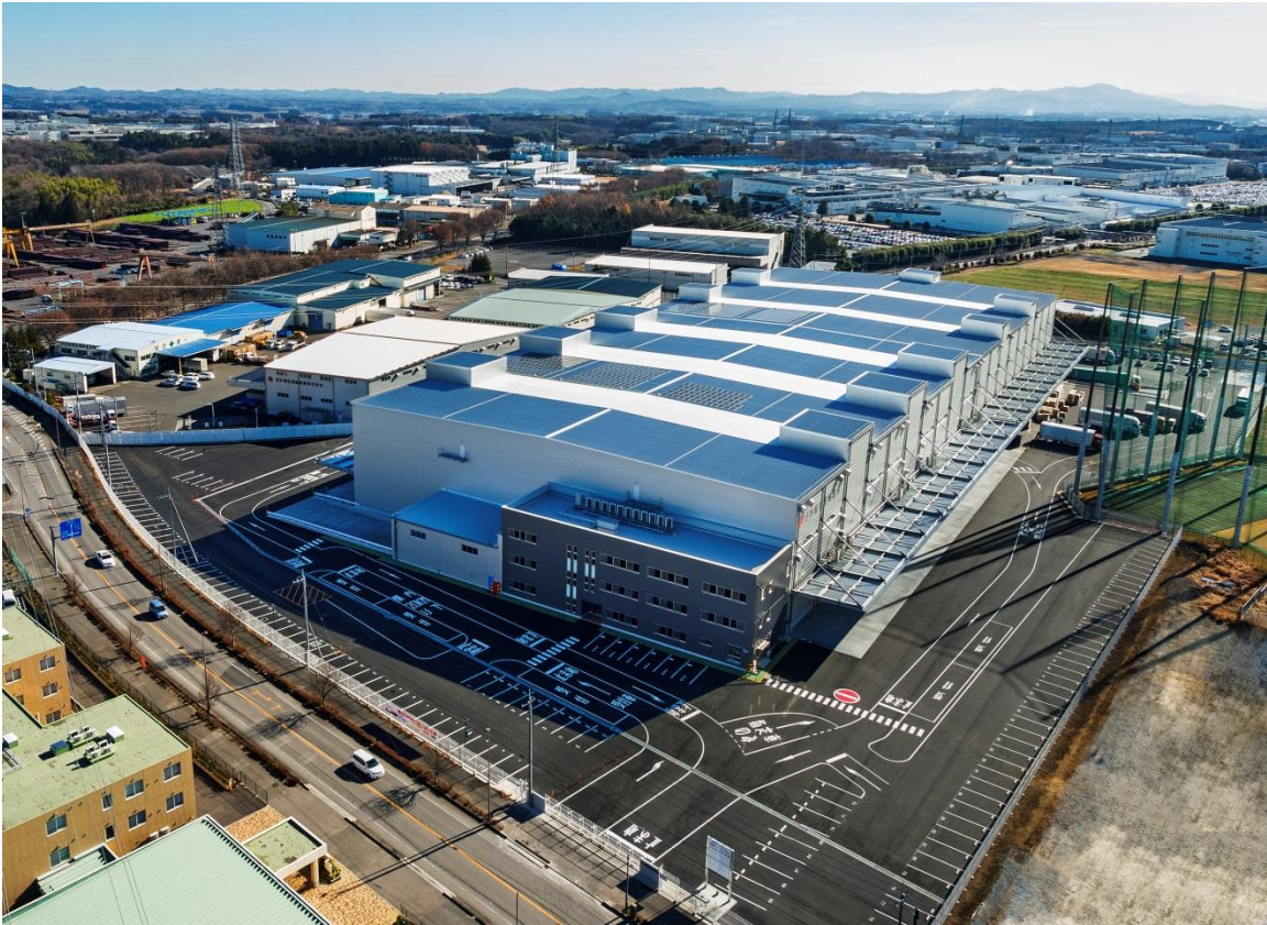
北西側から宇都宮倉庫全景（左手奥側が栃木営業所）
