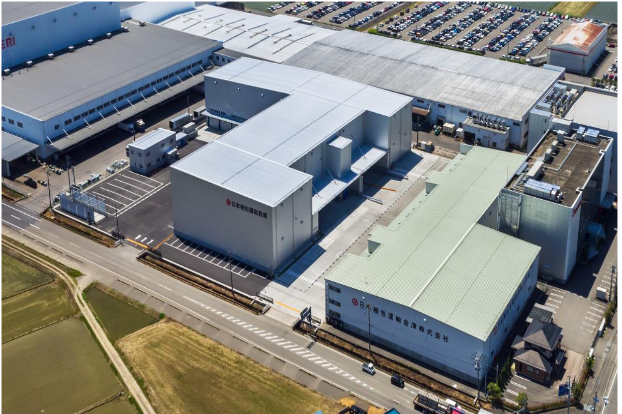
倉庫外観(航空写真)
